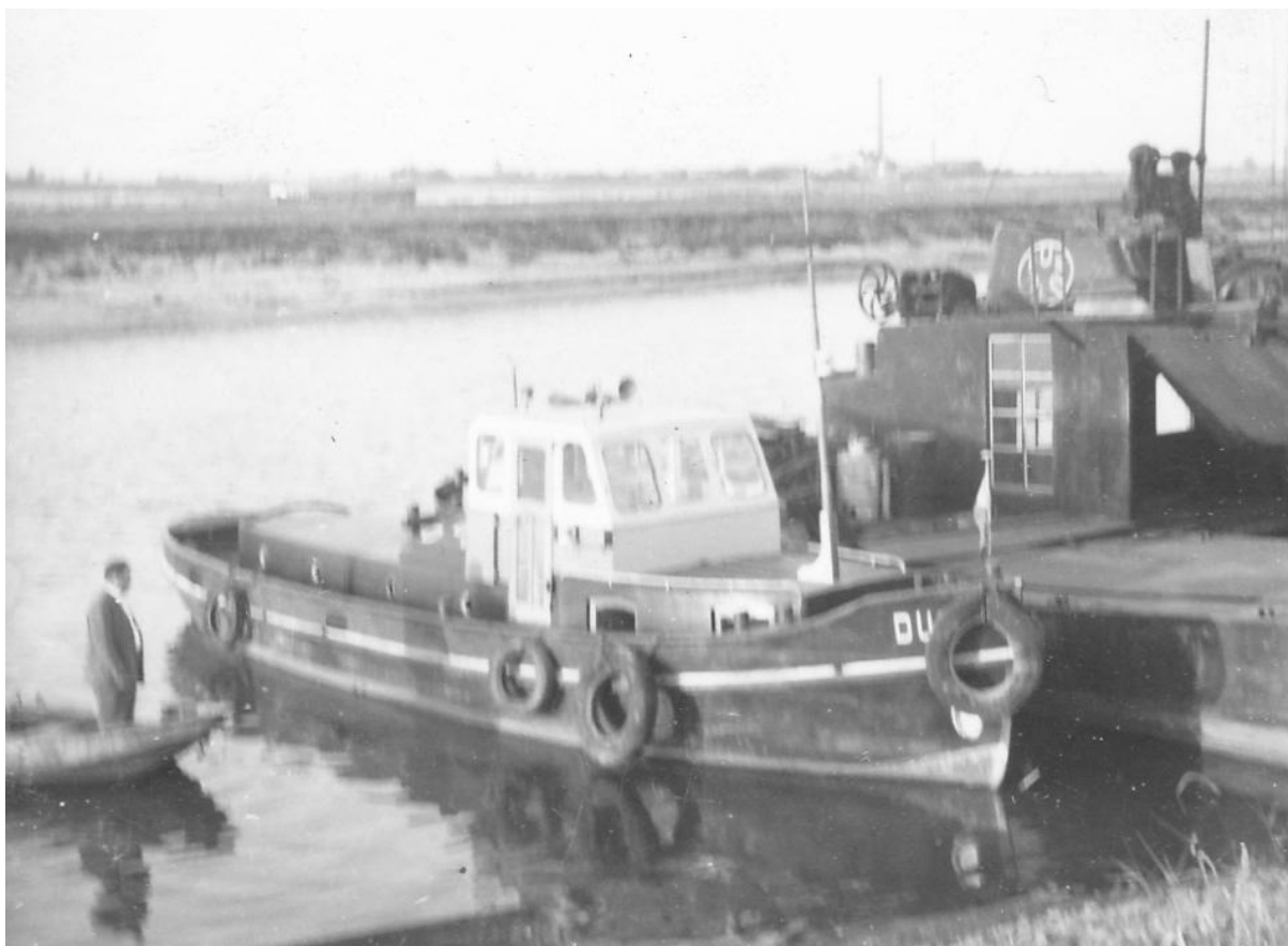
Van links naar rechts: Wiel Eltink in de roeiboot en de sleepboot Duo voor reparatie. Het ponton achter het werkschip is een zolderbak, in gebruik als werkplatform, liggend tegen de achterkant van het werkschip.
